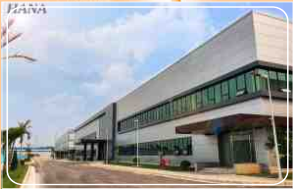
Nhà máy Hana Micro Bắc Ninh
